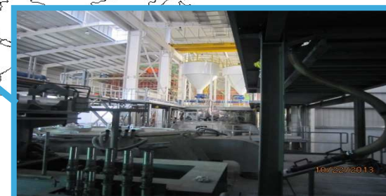
Usine d'alumine fondue Bahreïn
